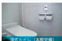
洋式トイレ（本館完備）
