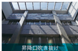
昇降口吹き抜け
